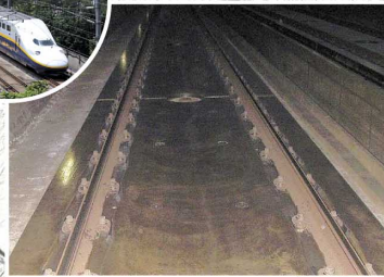
新幹線 軌道コンクリート
