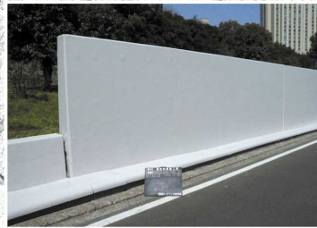
高速道路擁壁
