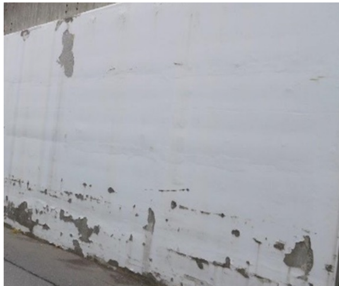
写真-10 被覆材の剥離・剥落
