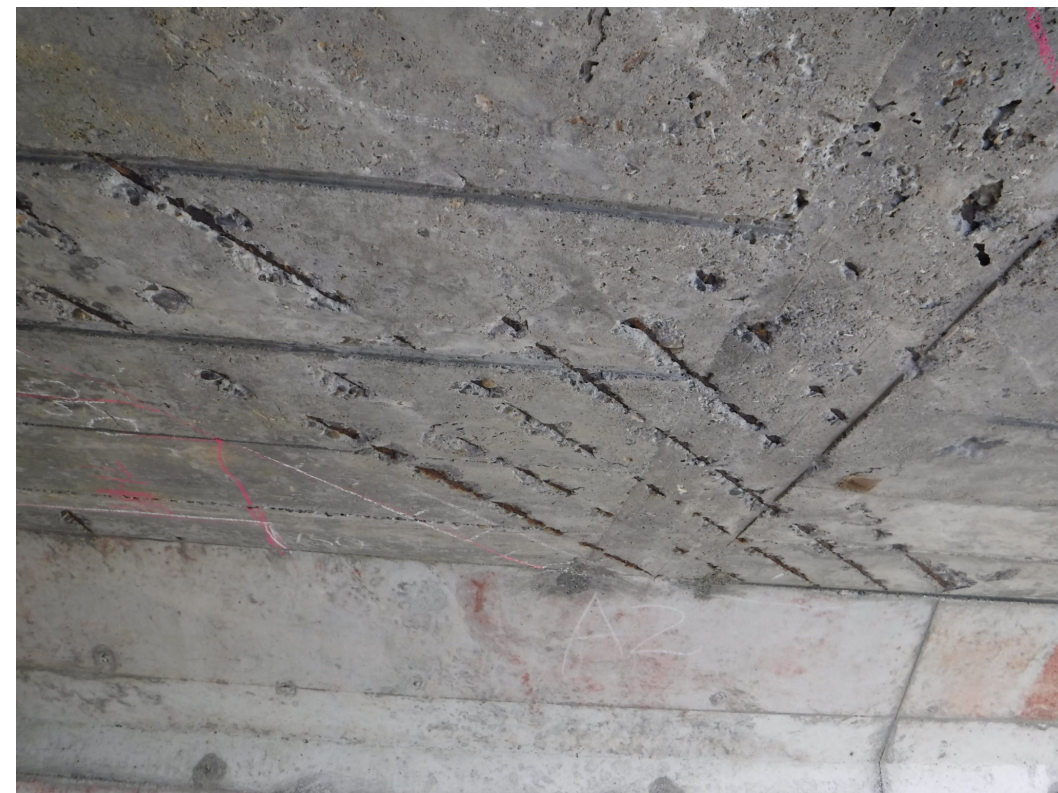
写真-14 被り不足のため鉄筋が露出
