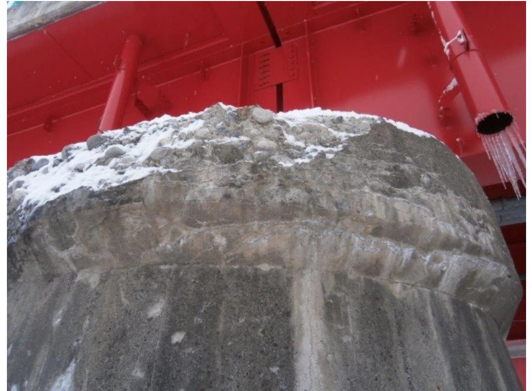
写真-4 水掛りによる凍結ひび割れ、 断面欠損
