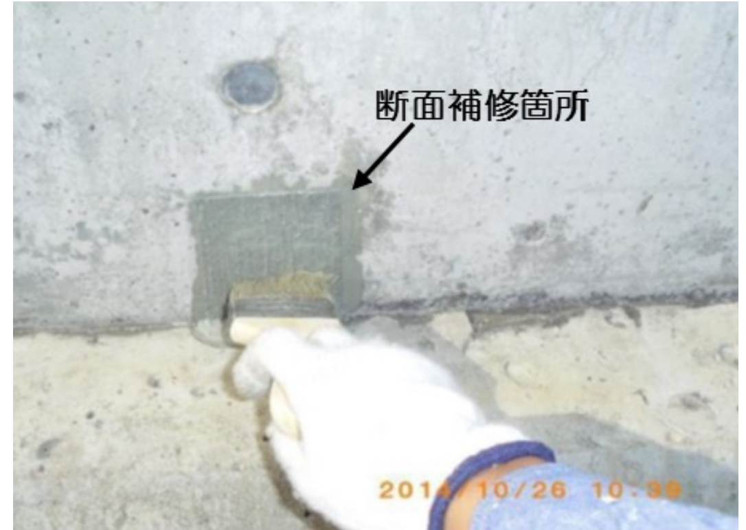
写真-9 断面修復後に防水材塗布
