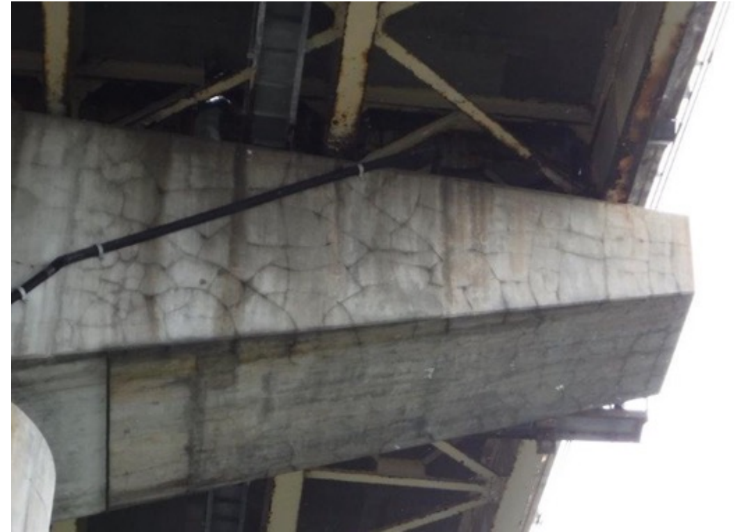
写真-2 上面の伸縮装置からの水掛り によるひび割れ
