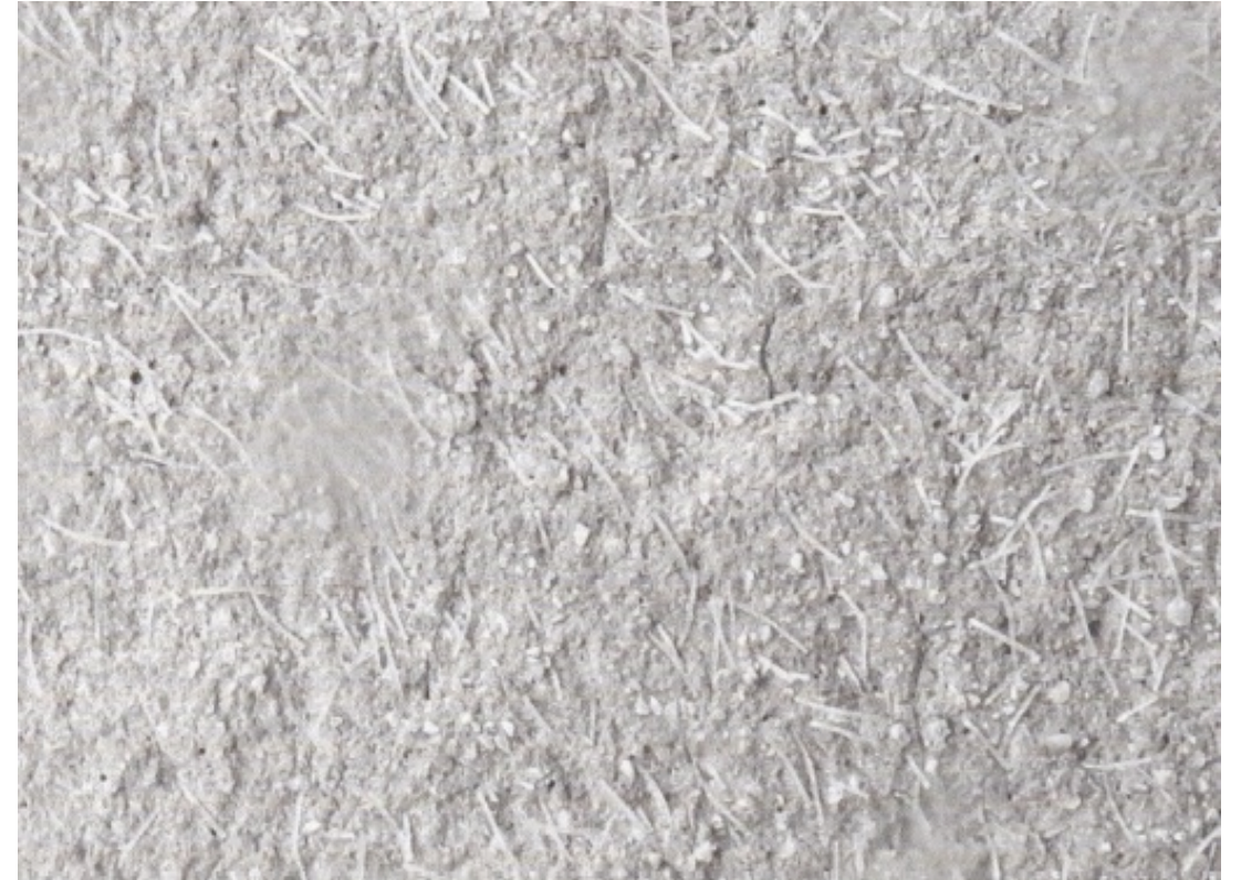
写真-11 摩耗により繊維露出
