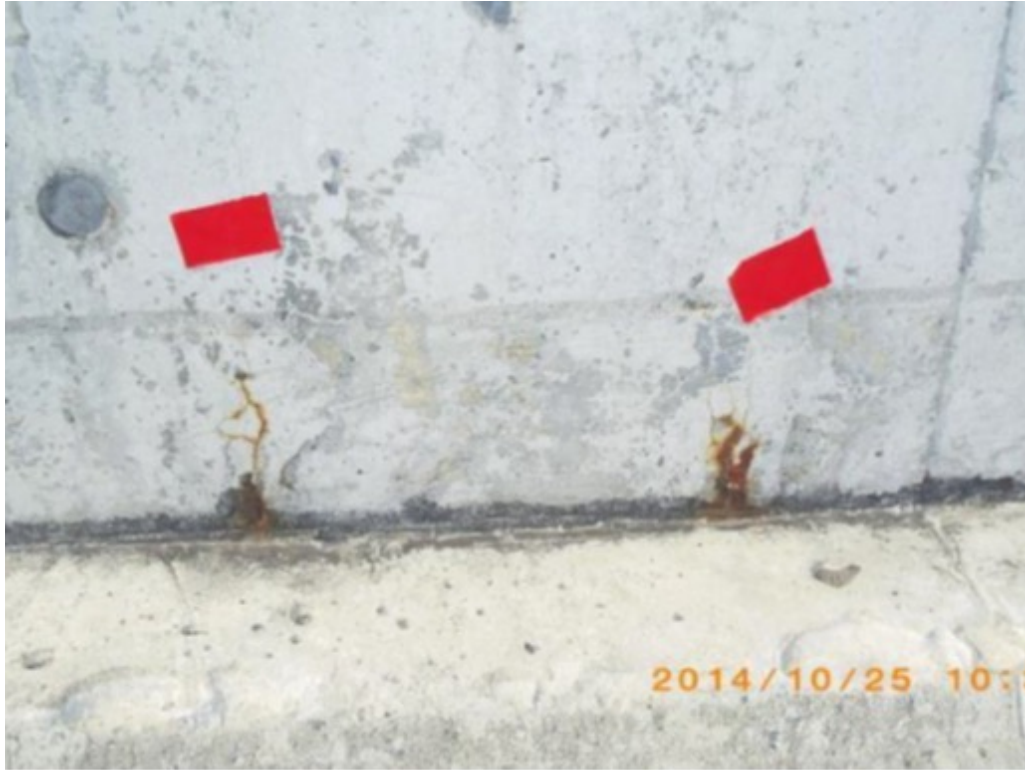
写真-8 鉄筋のかぶり不足による錆汁
